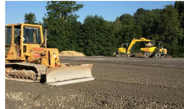
Der Strukturwert (a-Wert) von 1.4 erlaubt dünnere Schichten als mit ungebrochenem Material. Die Empfehlungen basieren auf den Erfahrungen vergangener Projekte. Sie werden durch technische Beratung für jedes Objekt präzisiert (Planung und Bau).
